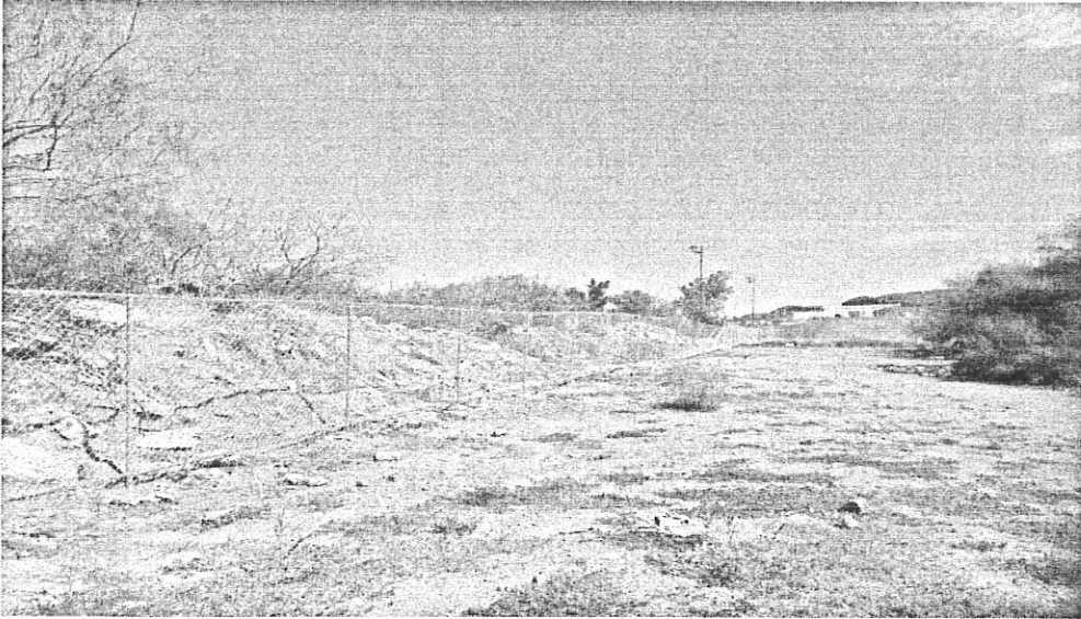
GUAYMAS-22-FMD-SJ-02 Construcción de barda y cerco perimetral en la Unidad Deportiva Sur, de Guaymas, Sonora.
